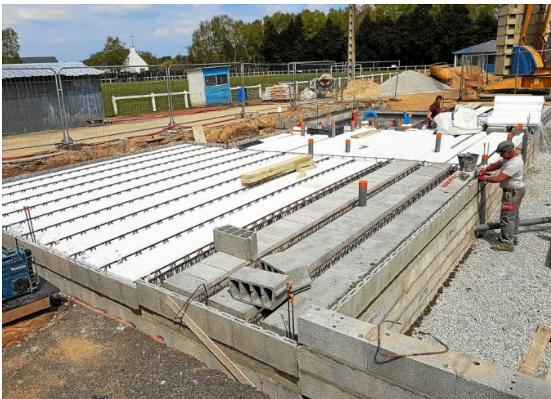
Ensemble sportif avec salle associative en construction
